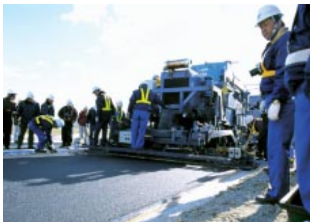
津市納所町国道23号での試験施工
