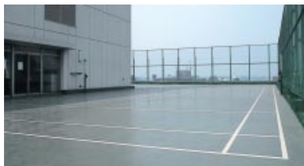
屋上に施工されたウレタン防水材
