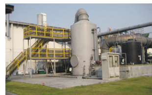
トラックバス用タイヤ工場側脱臭装置 (スクラバー)
