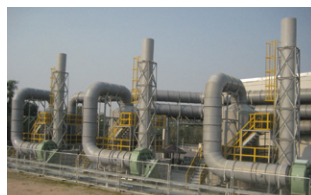
乗用車用タイヤ工場側脱臭装置 (スクラバー)
